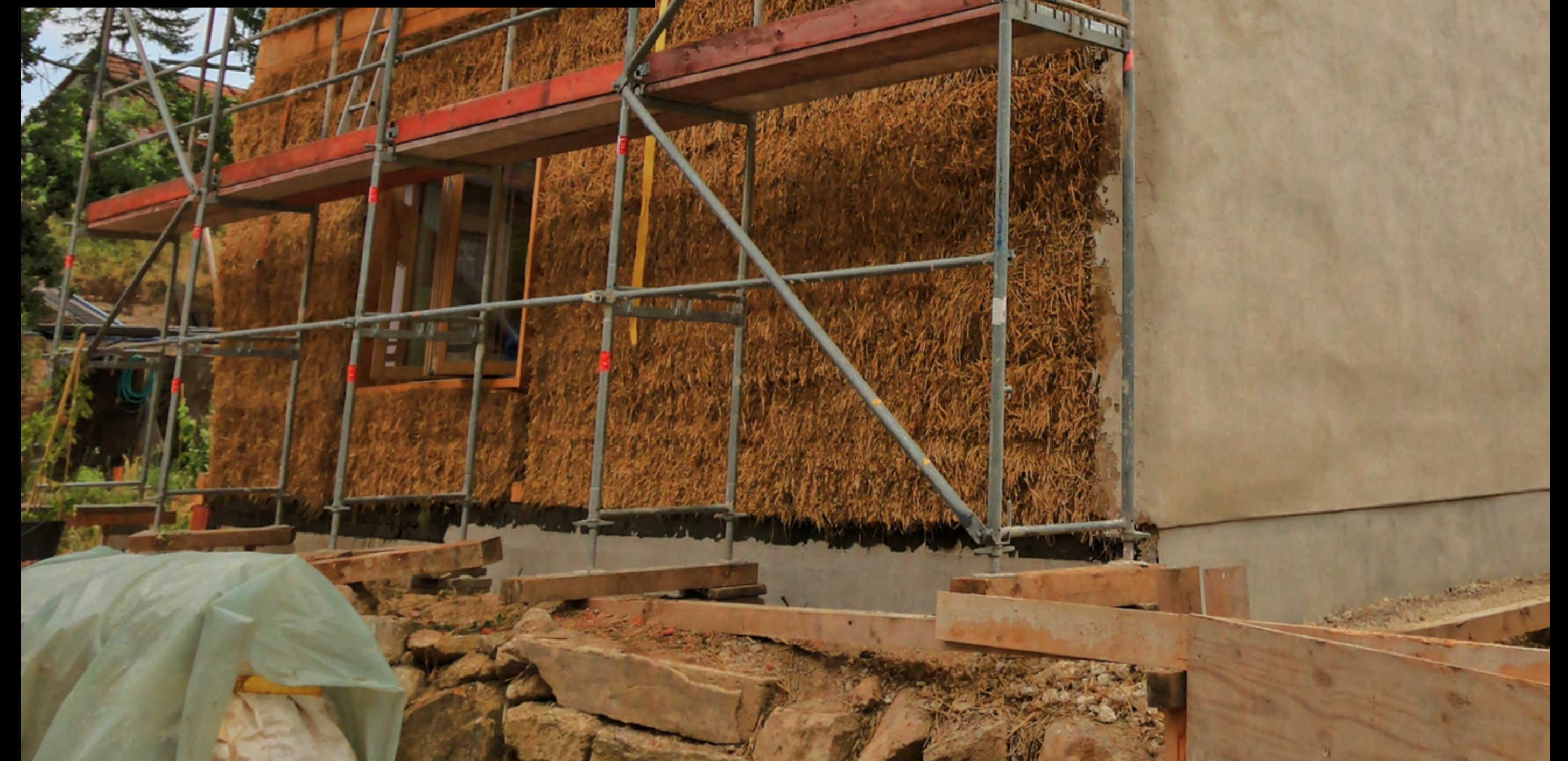
PUTZARBEITEN AN DER AUßENSEITE. KALKPUTZ UND DACHÜBERSTAND SCHÜTZEN DIE STROHBALLEN.
