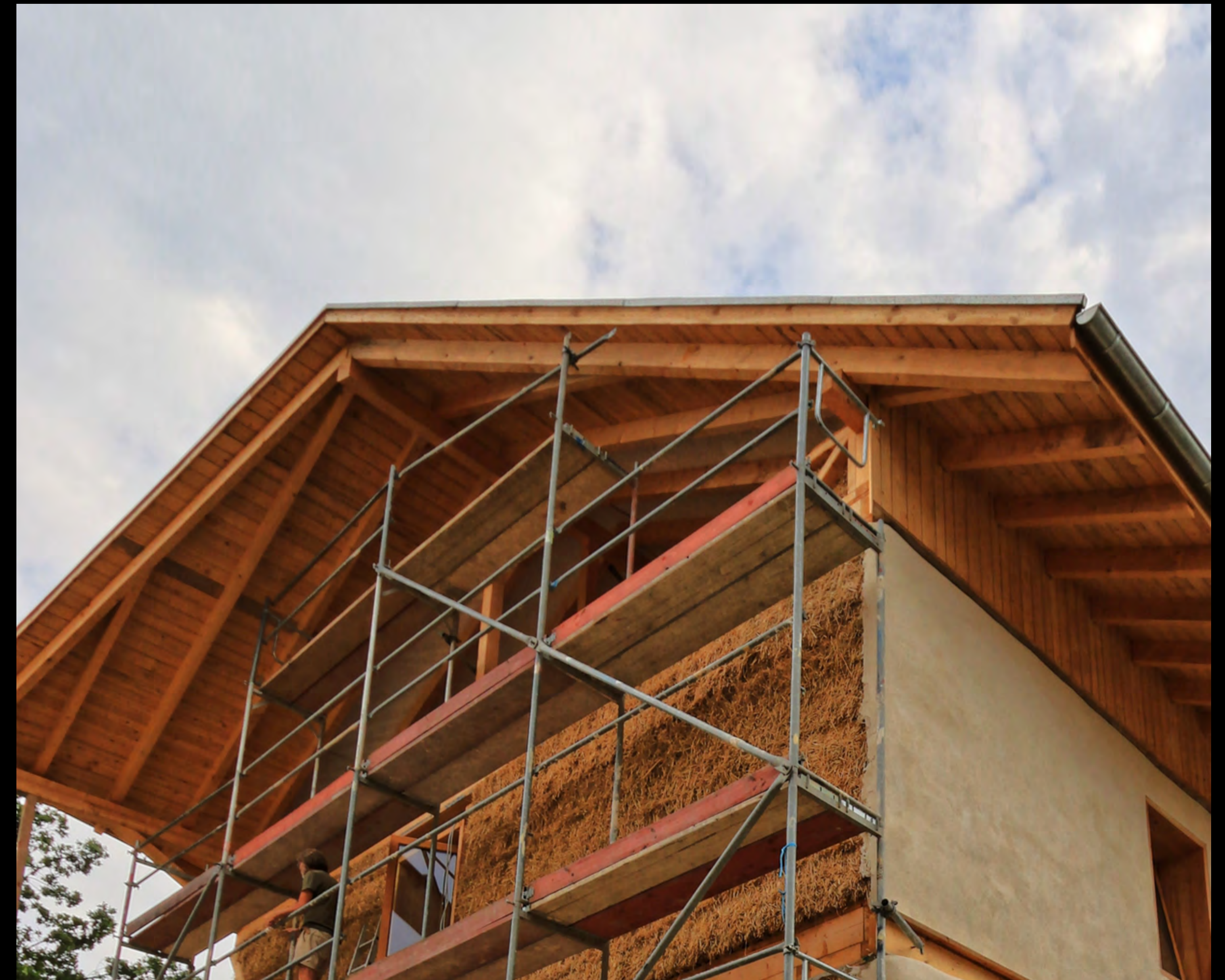
PUTZARBEITEN AN DER AUßENSEITE. KALKPUTZ UND DACHÜBERSTAND SCHÜTZEN DIE STROHBALLEN.
